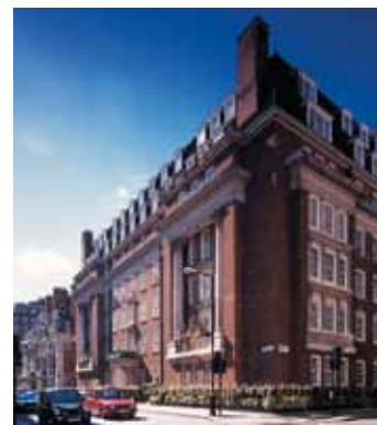
Отель Marriott 47 Park Street, Лондон, защита NI-FOG®
